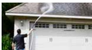
Lavado de fachadas Lavagem de fachadas
