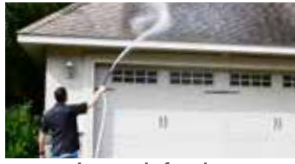
Lavage de façades Fassadenreinigung
