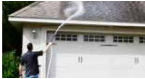
Lavage de façades Fassadenreinigung
