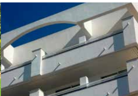
Waterproofing treatment spraying on walls and terraces. Irrorazione di impermeabilizzanti su muri o terrazzi.
