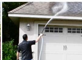
Soft wash Lavaggio facciate
