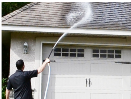
Soft wash Lavaggio facciate
